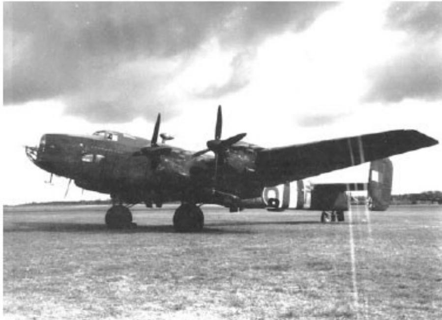
Eine Halifax MV, Rolls Royce Motoren, Flügelspannweite 99 feet (30,18 m). Dies ist fast identisch mit einer Lancaster, jedoch die Form der Halifax gleicht einem „H“, während die Lancaster einem „L“ gleicht.
