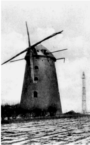
Oberaußemer Windmühle in den 1930ige Jahren. Rechts im Hintergrund das Leuchttfeuer der Flugstrecke Köln – Brüssel.
