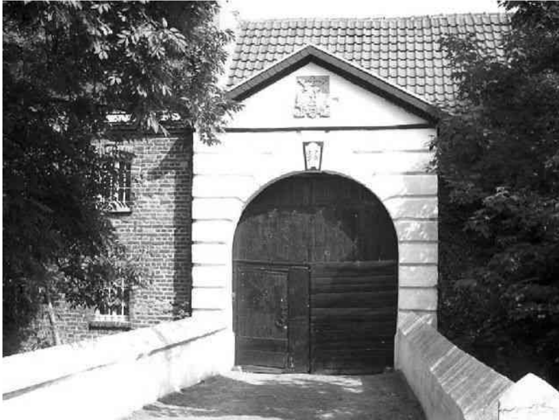
Toreinfahrt Haus Asperschlag, 2006
