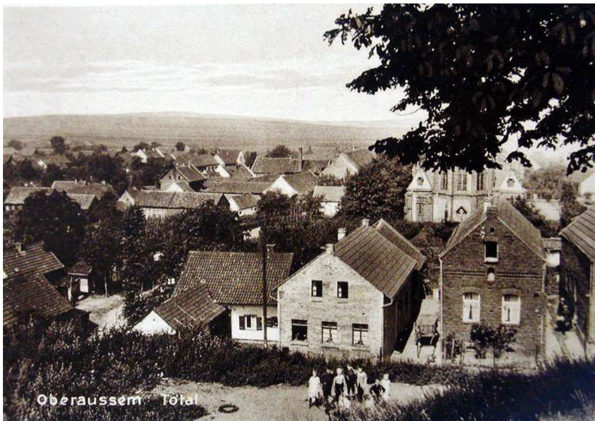
Die zum Anwesen Kaufleute Schmitz gehörigen beiden Wohnhäuser Bergstrasse Nr.10 re. u. Nr. 12 mit dem langen Hof und den Nebengebäuden etwa gegen 1930
