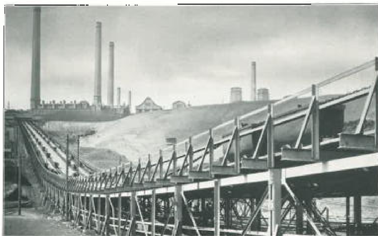
Zweigeschossige Seilbahnanlage auf Grube „Fortuna“
