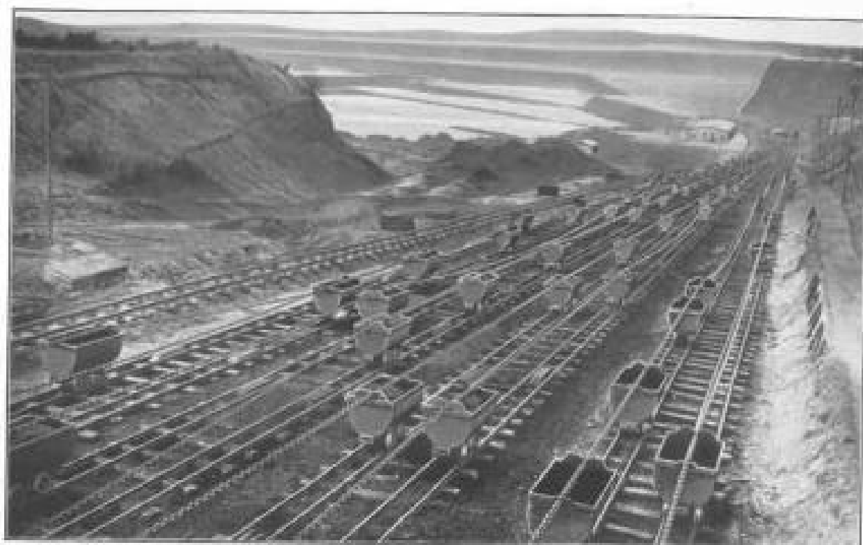
Kettenbahnanlage für die Kohlenförderung des „Grublerkes“ 1926 (vor der Umstellung auf Großraumförderung)
