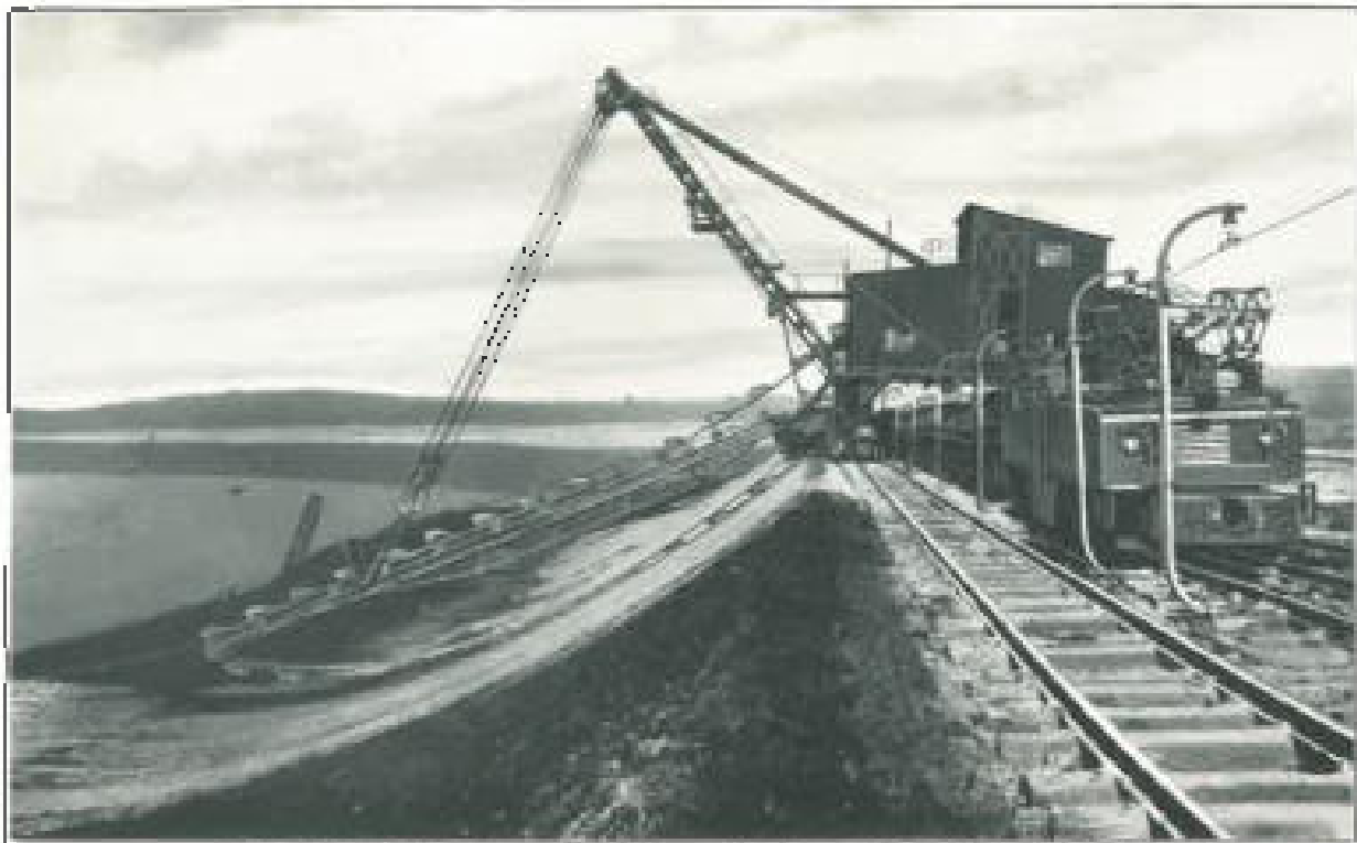
Elektrische Zugförderung im Abraumbetriebe auf „Grühlwerk“ 1928
