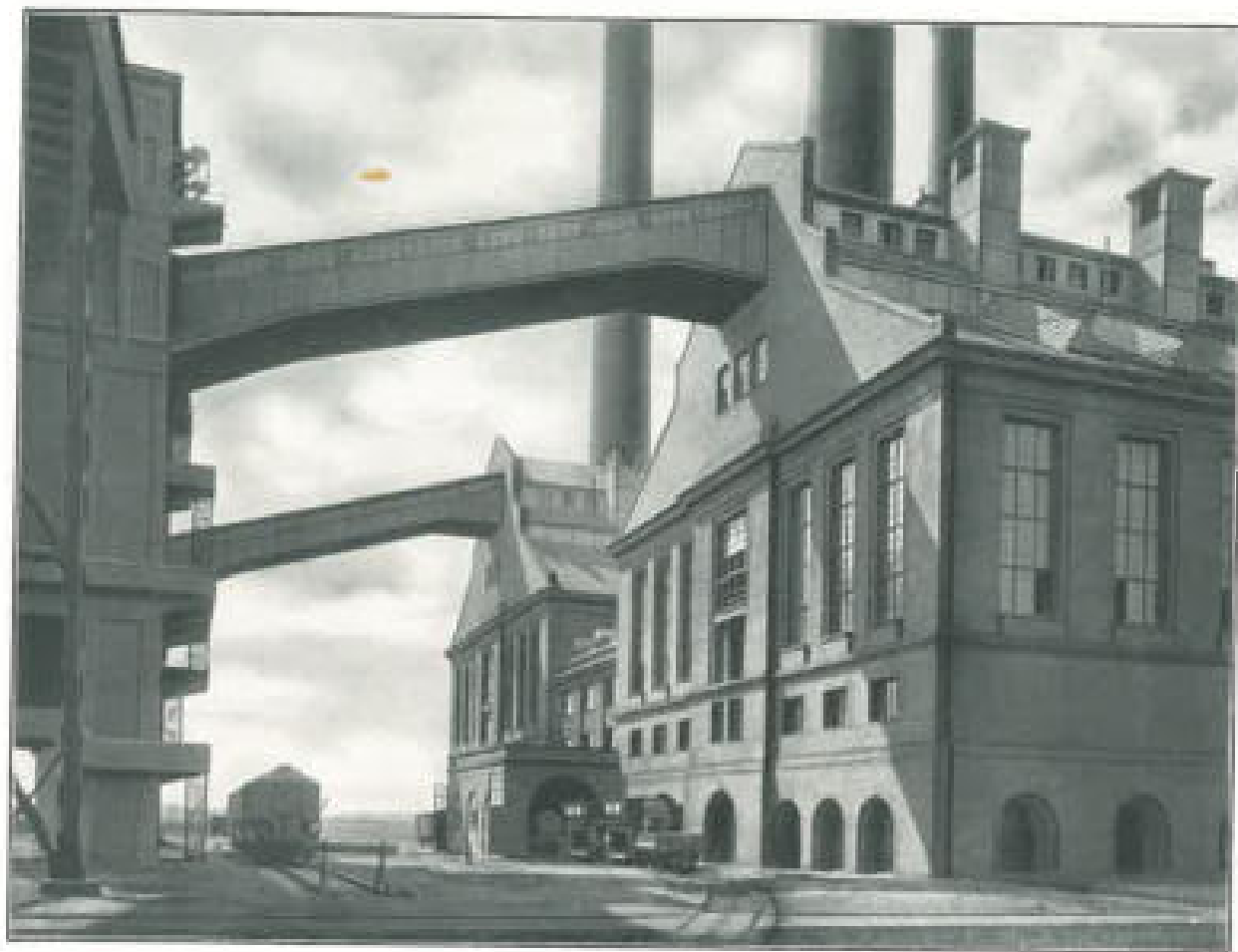
Die beiden Kesselhäuser des Kraftwerkes „Fortuna II“ mit Brikettsanlage
