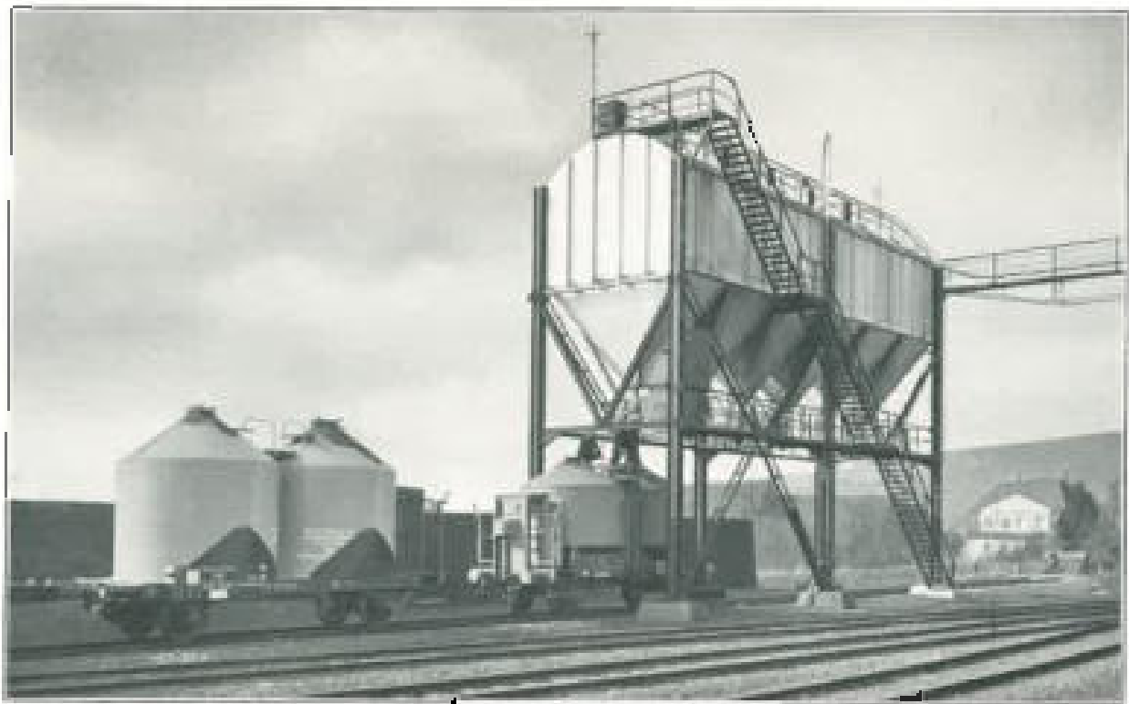
Eisenbahn-Verfahrs-Anlage für Kohlenstaub auf „Beißelsgrube“
