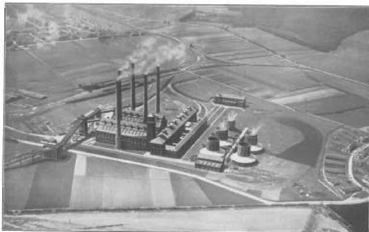
Kraftwerk „Fortuna II“; Ansicht aus der Vogelschau
