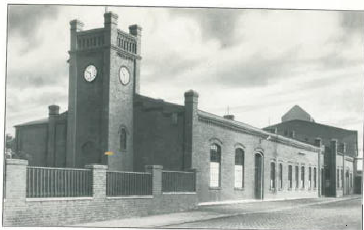
Das erste Verwaltungsgebäude der „Fortuna“ Akt.-Ges. auf Grube „Fortuna“ bis 1905
