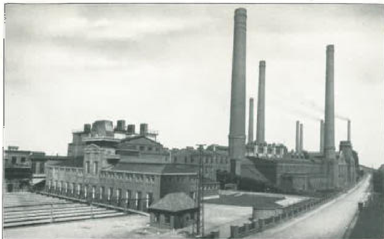
Gesamtansicht der Ziegelei I auf Grube „Fortuna“ dahinter die Kraftwerks-Anlagen
