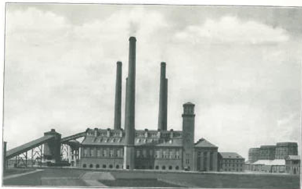
Kraftwerk „Fortuna II“: Außenansicht
