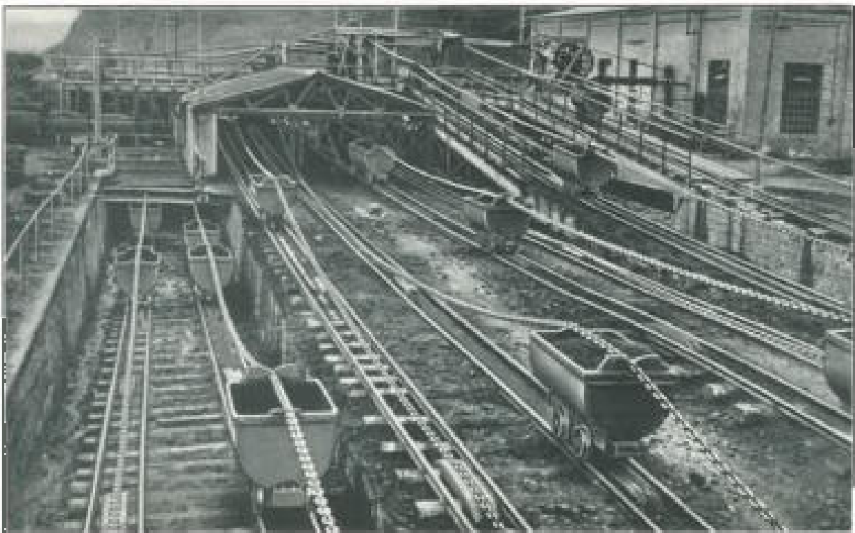
Kettenbahnanlage für die Kohlenförderung des „Grühlwerks“ 1926 (vor der Umstellung auf Großraumförderung; siehe auch nachfolgendes Bild)
