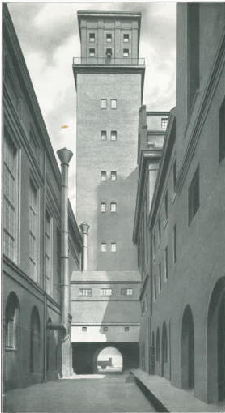
Durchblick zwischen Maschinenhaus und Kesselhaus am des Kraftwerkes „Fortuna II“
