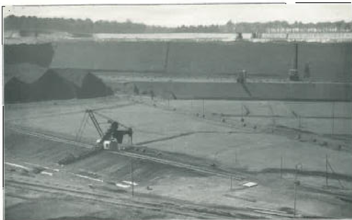
Blick in den Tagebau der Grube „Fortuna“ um 1911 (Maschinelle Kohlengewinnung — besehen noch Kohlenentladung von Rand)
